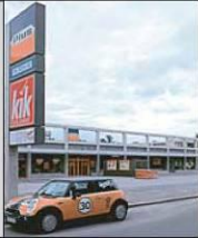
Nonvereinigungszenitium Hon.-Mattenwerder - Projekt / Bau 2003 / 04
